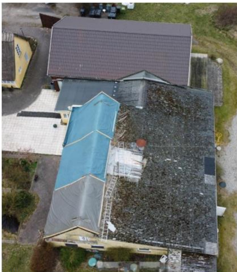
Billede 2: Bygning 4, overblik
