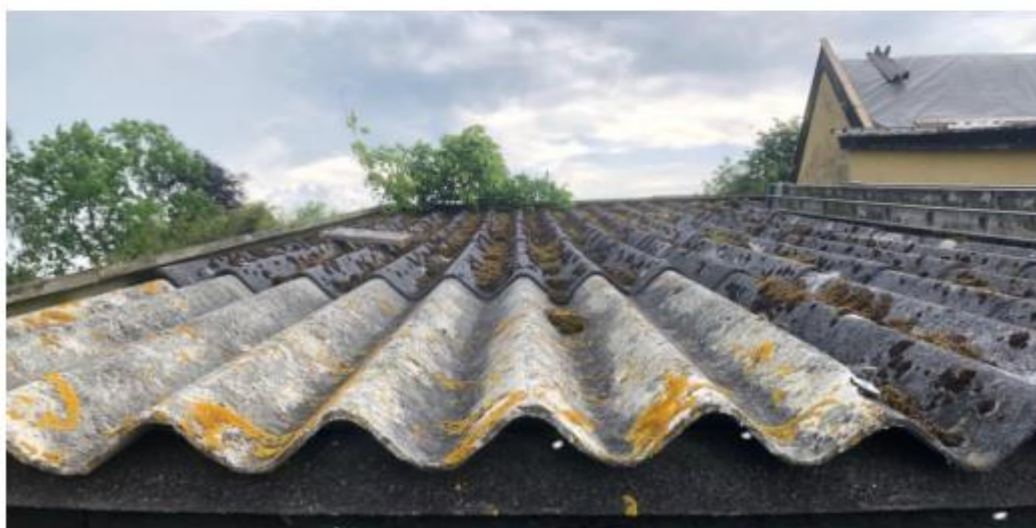
Billede 9: Mulighed 2) Som taget på svinestalden: noget i stil med gråt bølgeeternit
