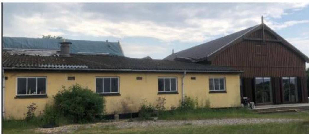
Billede 7: Bygning 4 set fra nordøst
