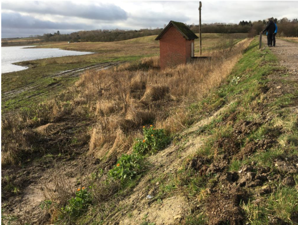
Asserholmdæmningen med det lille røde pumpehus giver et fint udsyn over området. Og mens dæmningen i dag sikrer motorvejen mod ekstremt højvande, har pumpehuset ikke længere nogen funktion. Foto: Birgitte Ingrisch
