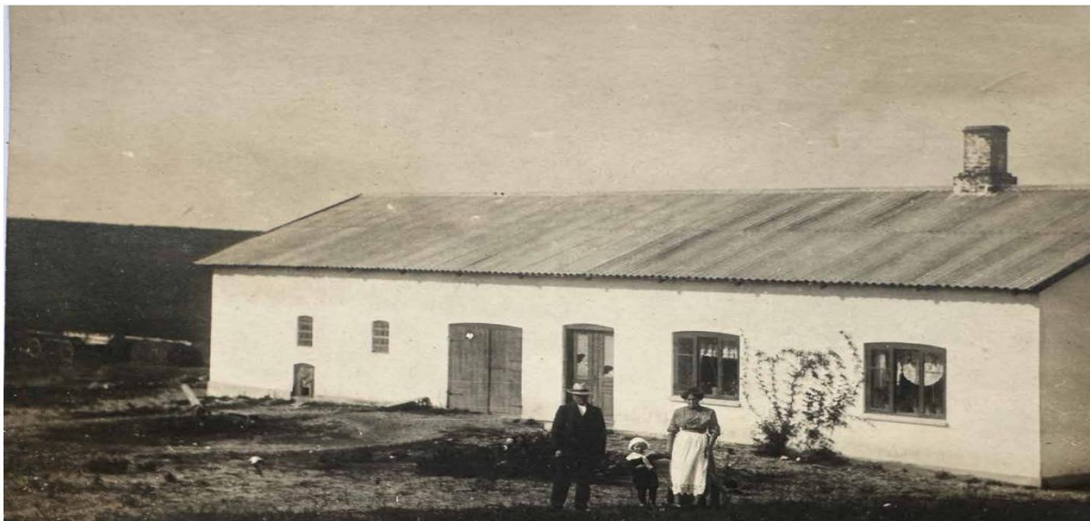
Fotos fra 1920, med de første beboere, der byggede huset. På dette foto ses den store port til stalden, samt den lodrette opdeling af vinduerne. Taget er metalpladetag.
