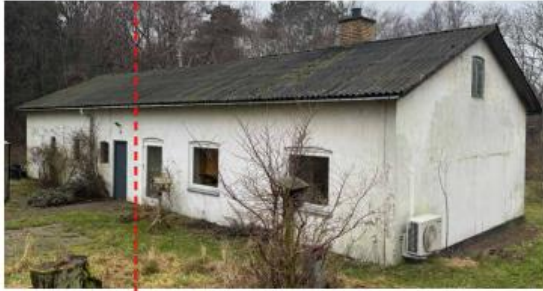
2. Udhus (stald) 1. Stuehus til landbrugsejendom, opført 1913, 63 m 2 , samt tagetage 50m 2
