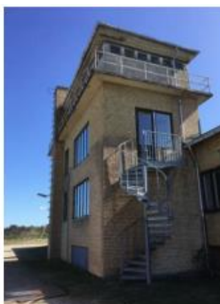
Radiostations bygninger har stået ubenyttet hen siden radiostationen lukkede i 2009. Fotos: Birgitte Ingrisch
