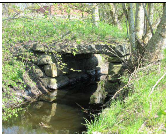
Figur 3: Stenkisteformet bro over Tåstrup Bæk. Foto: Ann Berit Frostholt
