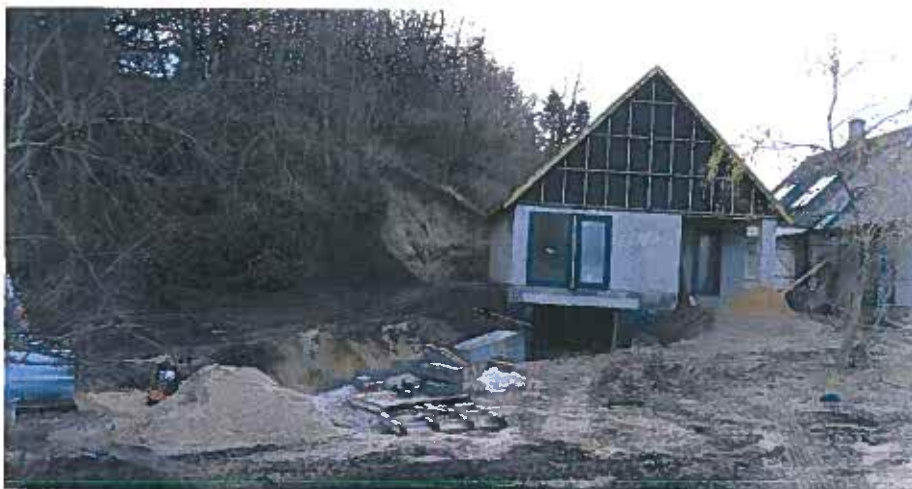
Åbningen af terrænet ned til underjordisk kælder/garage.
