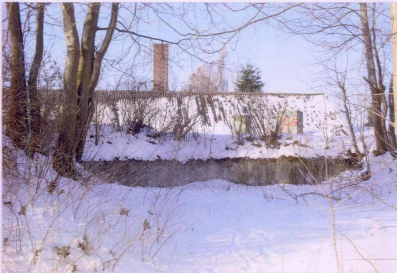
En af de seks kanonbriske er bevaret i en tilstand, så den kan frilægges og fremvises. Det er betegnelsen for standpladser bag brystværnet hvor kanonen blev opstillet og betjent. Pladsen var støbt i beton og skrånede fremad mod brystværnet for at optage rekylet.
