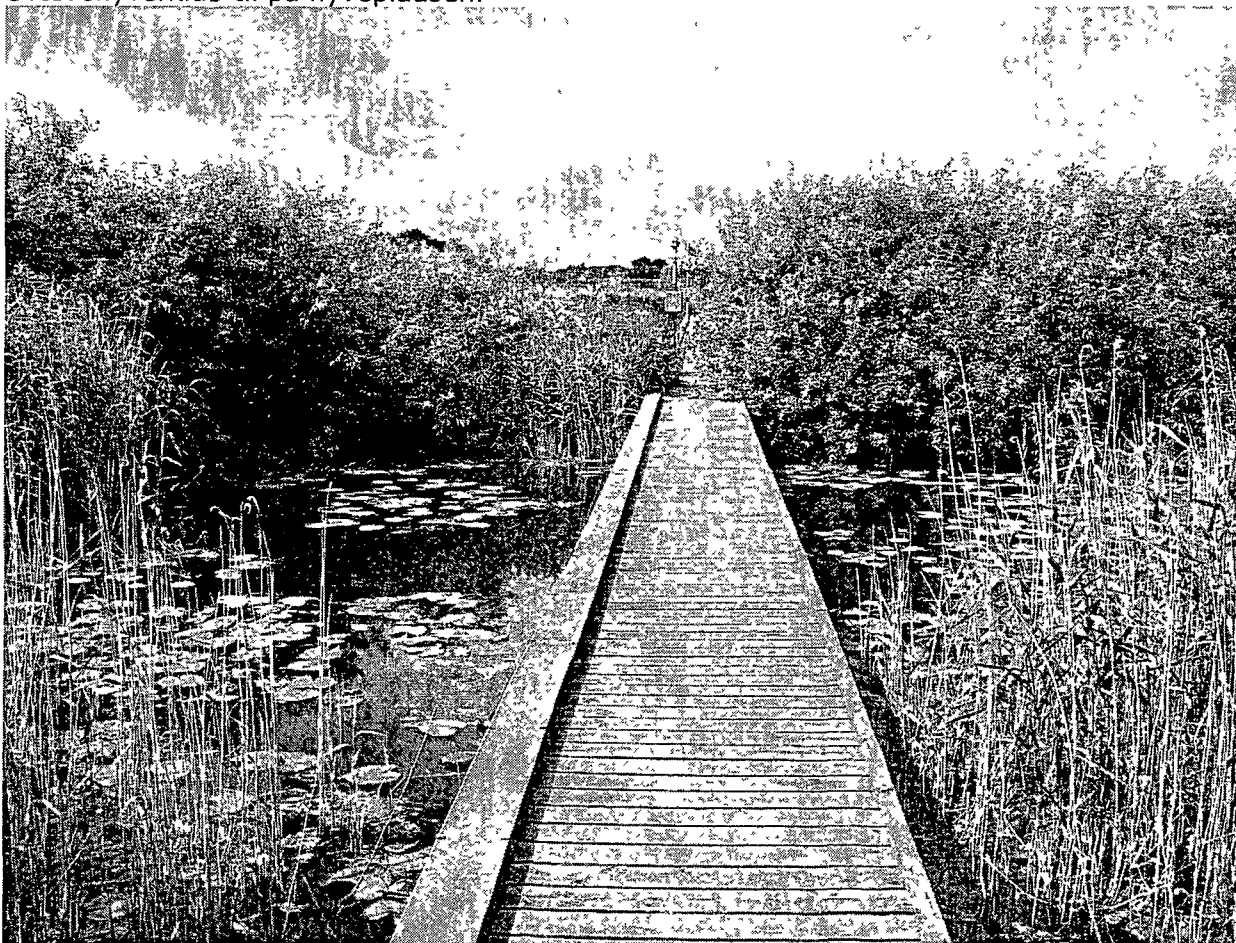
Der er bygget træbroer på tværs af Bringe Mose til gavn for bl.a. fugleinteresserede besøgende.
