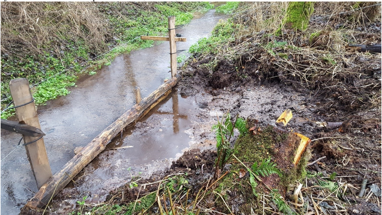
Der skal efterfølgende lægges trædesten på den blotlagte brink for at forhindre yderligere erosion. Stenene dækkes med det opgravede materiale, hvorved stenene bliver mindre synlige, ligesom terrænreguleringen bliver mindre end det, der ses på ovenstående billede.
