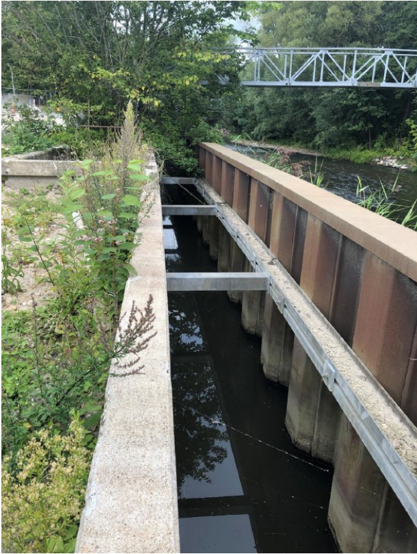
Eksisterende hulrum mellem betonmur og spuns der opfyldes ifm. projektet
