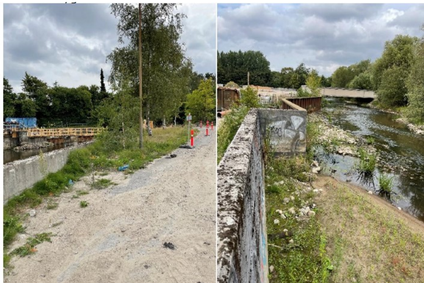
Område hvor eksisterende betonmur nedskæres og der etableres grønt areal og stenkastning ned mod åen
