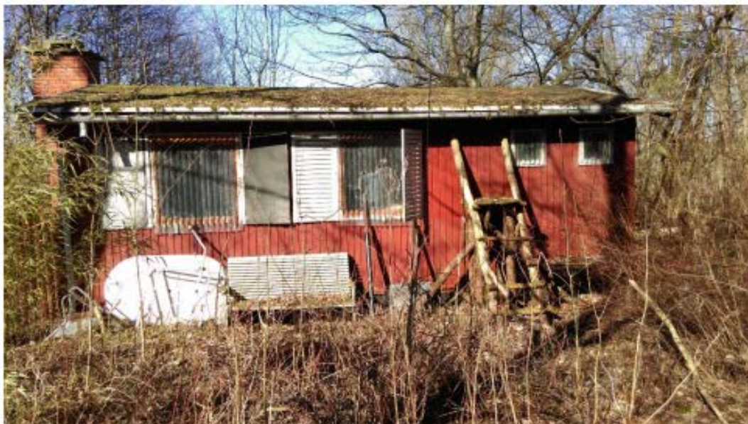
Figur 1: Den eksisterende bygning der findes på grunden. Bygningen har et areal på ca. 48 m 2 . Denne ønskes nedrevet og erstattet af en mindre bygning.
