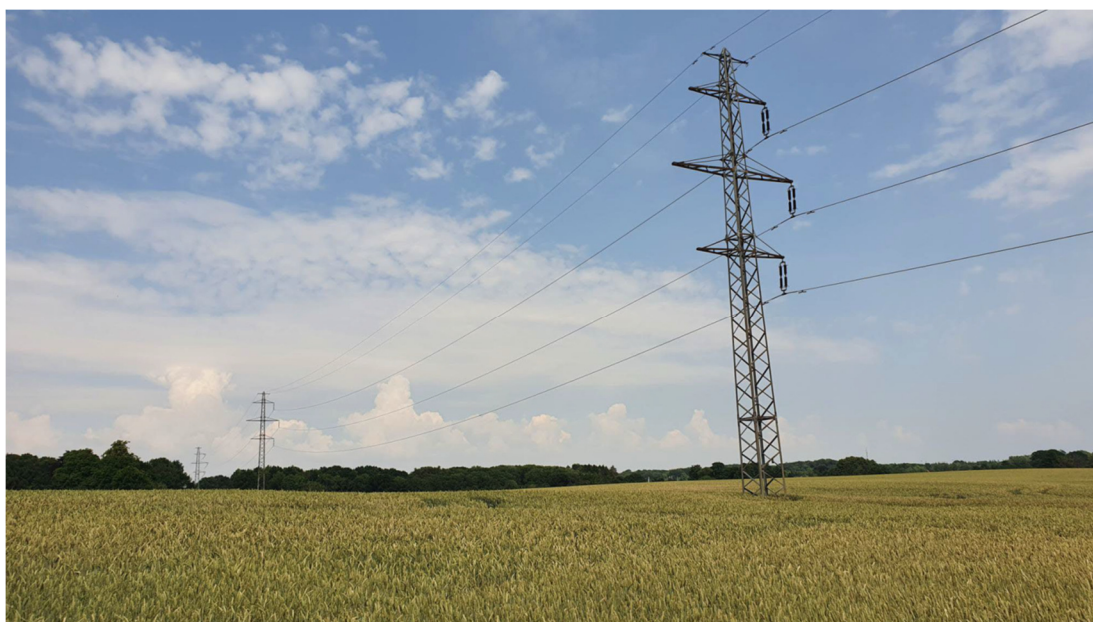
Figur 3.4. KAM-SPA luftledningsanlæg, som skal fjernes.
