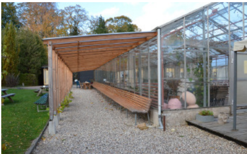
Pergola med bæk, bygning nr. 8 - Pergolaen, nr. 8 er et halvtage over en lang siddebænk ud til haven.
