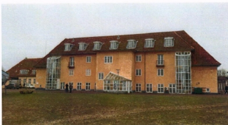
Eksisterende facade mod nord. I forbindelse med at værelser flyttes mod nord, ændres eksisterende vinduer og kviste til franske altaner for bedre udsigt over landskab og hav. Vindfang, trappetårne i glas samt oprindeligt trappetårn er indenfor fredningsgrænse.
