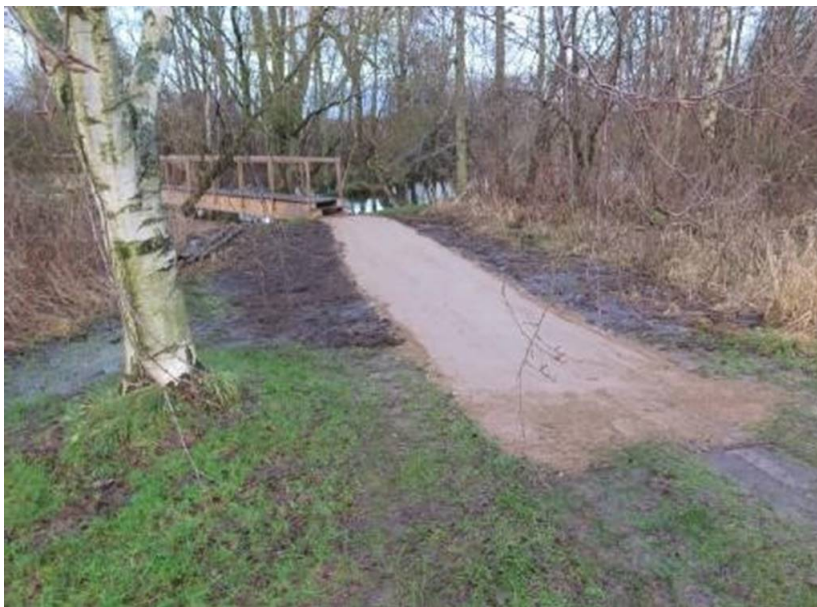
Syd for broen er anlagt grussti. Lovliggørende dispensation ift. Fredningen.
