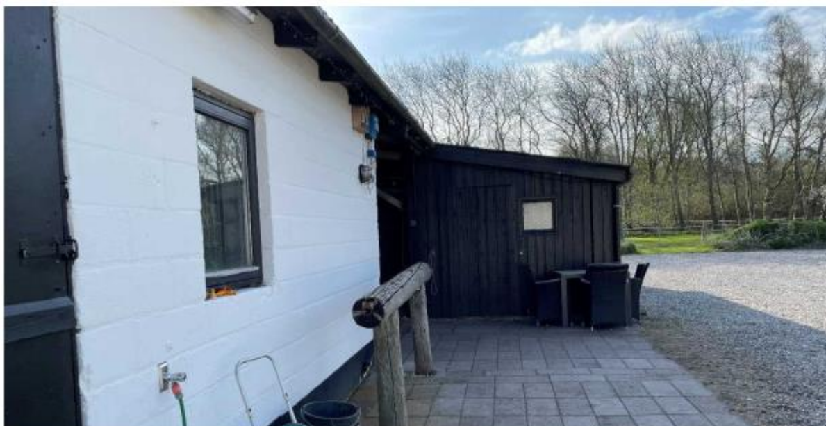
Stald facade i gasbeton mod syd samt facade mod vest
