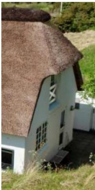
Huset set fra øst.
