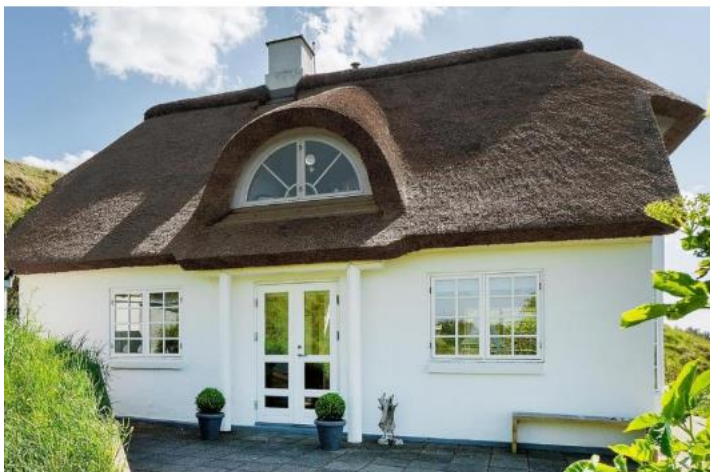
Huset set fra nord.
