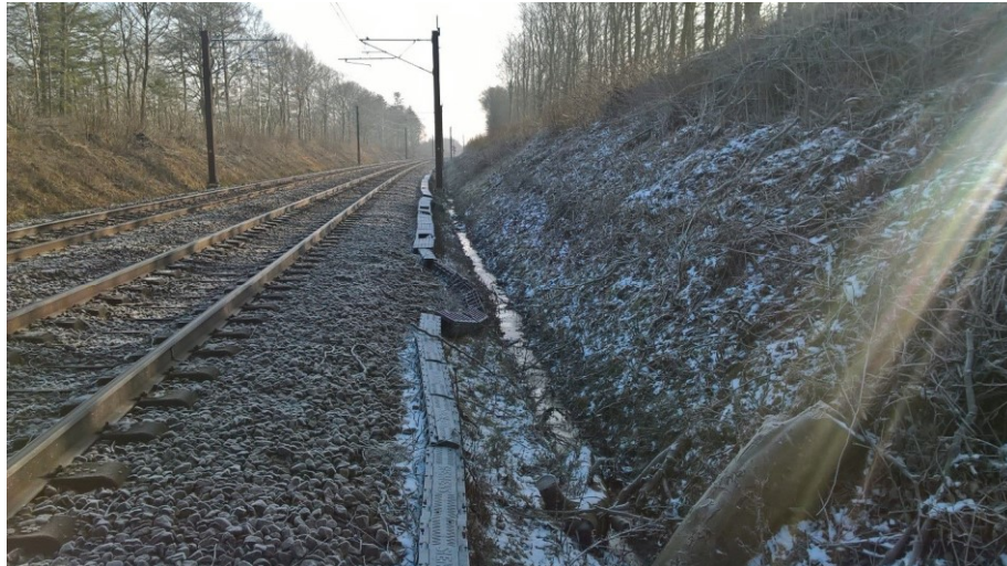
Figur 3 Billede af jernbanestrækning md køreledningsanlæg
