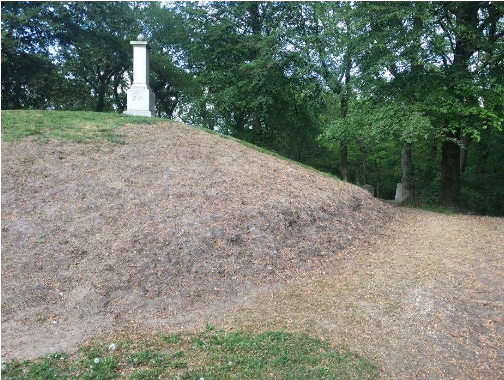
Skade på gravhøj, hvor højfoden ønskes reableret.
