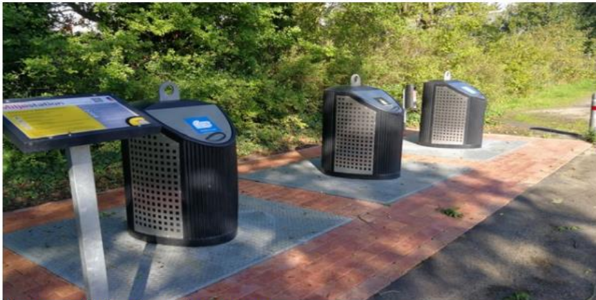
Eksempel på helt nedgravede containere
