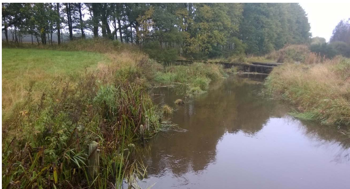
Figur 12 Stem og fødekanal til Risbøl Dambrug
