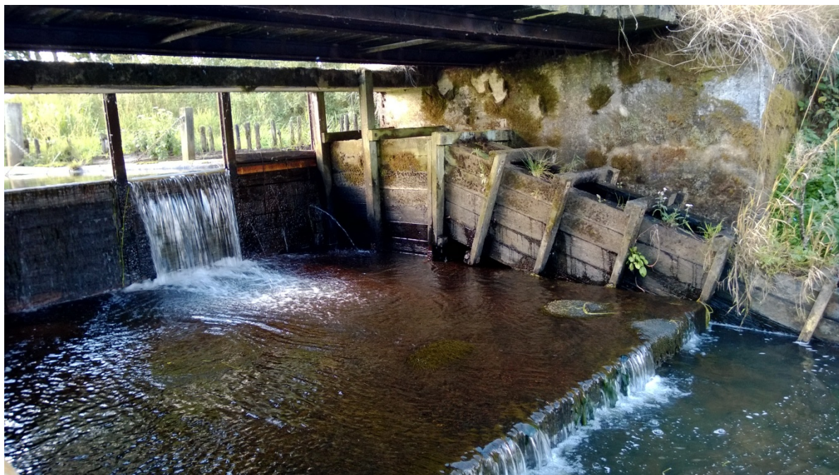
Figur 3 Opstemningen ved Risbøl Dambrug, hvor den gamle fisketrappe ses langs opstemningens venstre side.
