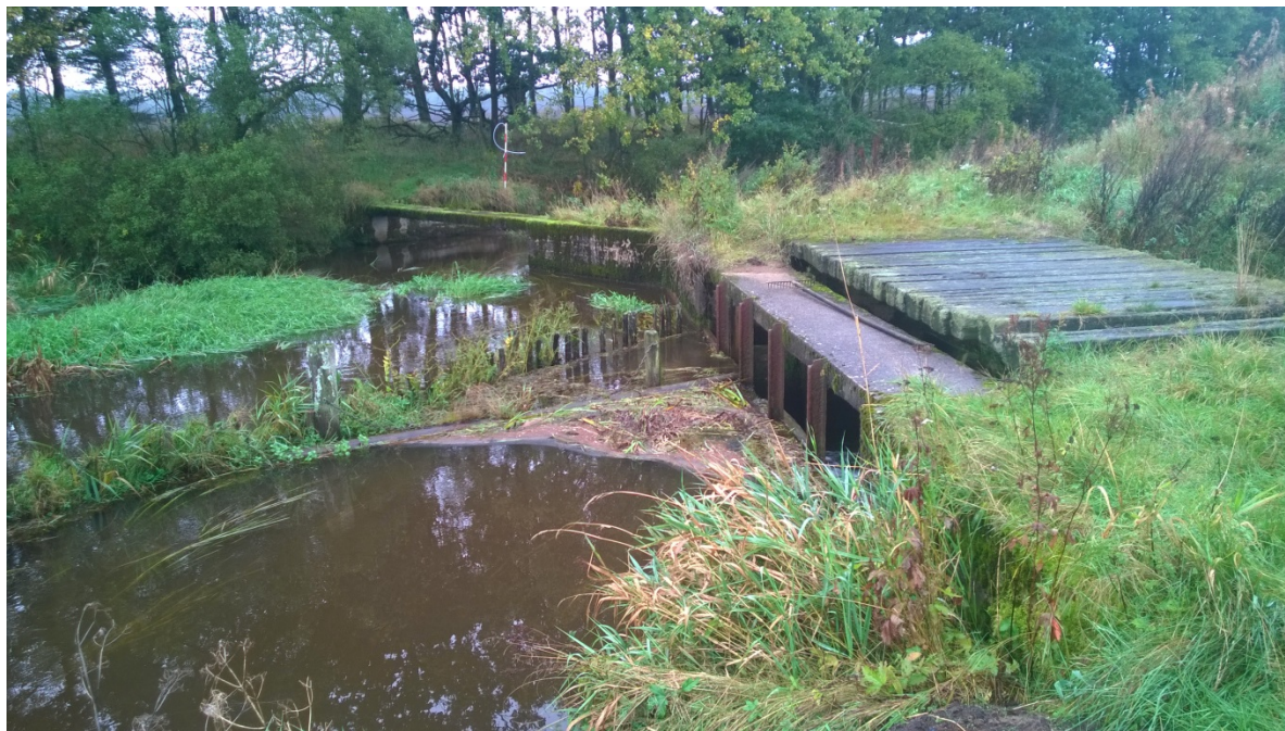
Figur 2 Opstemning for Risbøl Dambrug. Indløbet kan ses i baggrunden af billedet.
