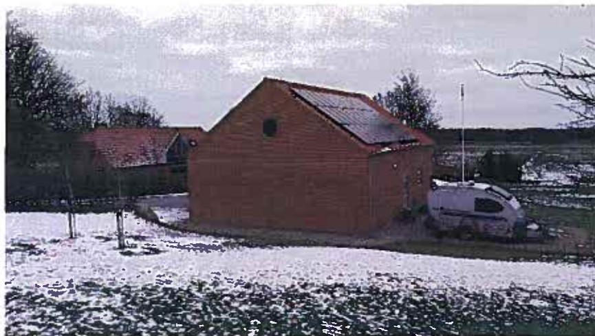
Solcellerne på taget af ejendommen Jelshøjvej 101.
