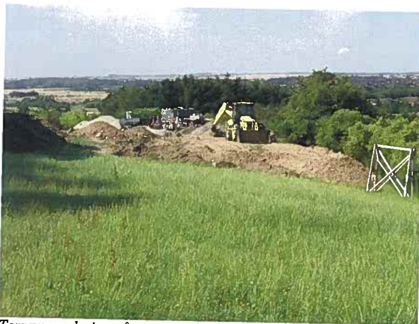
Terrænregulering på matr. nr. 2c Gunnestrup By, Tranbjerg. Den 24. juli 2014.
