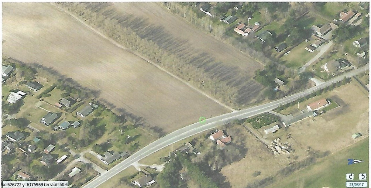
Skråfoto med Røsnæsvej i forgrunden fra:
