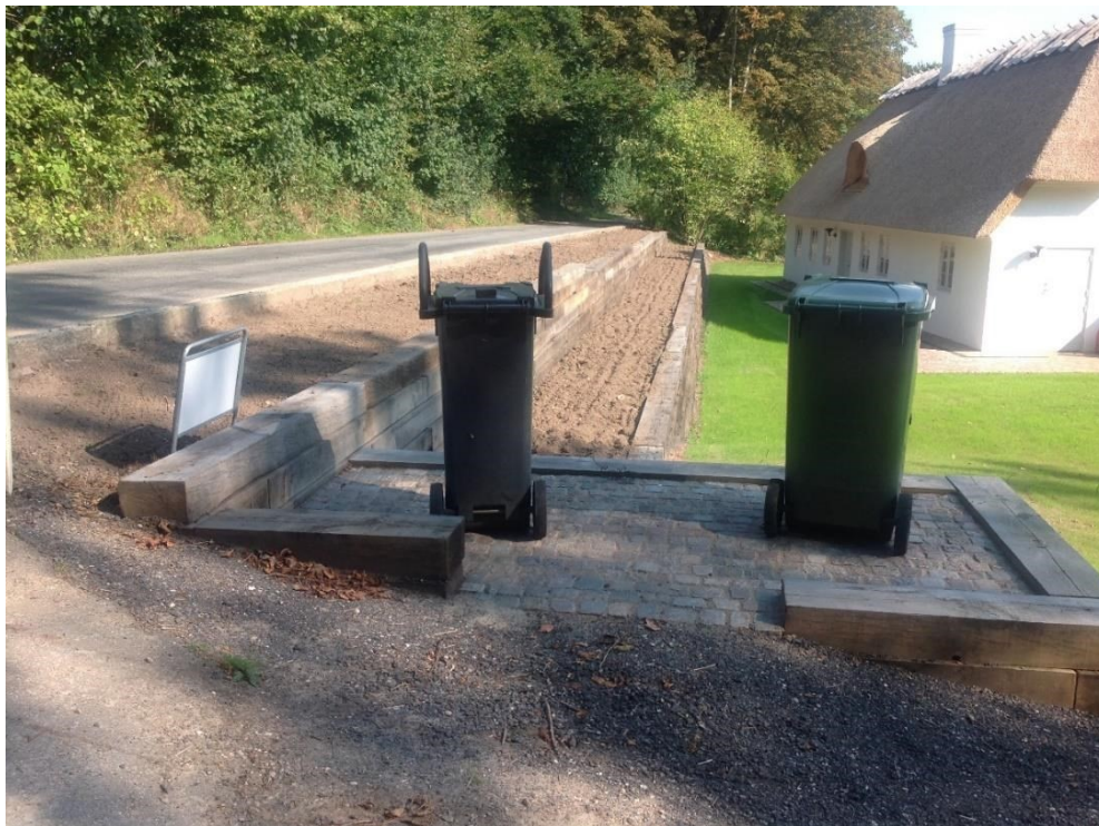
Billede 4: Støttemur i træ langs vejen. Ud for hjørnet af huset er støttemuren ca. 3,65 m bred og er således ca. 1,65 m inden for fredningen. Græsplænen terræn vurderes at være ca. 2,1 m under vejens. Foto: Vejen Kommune.
