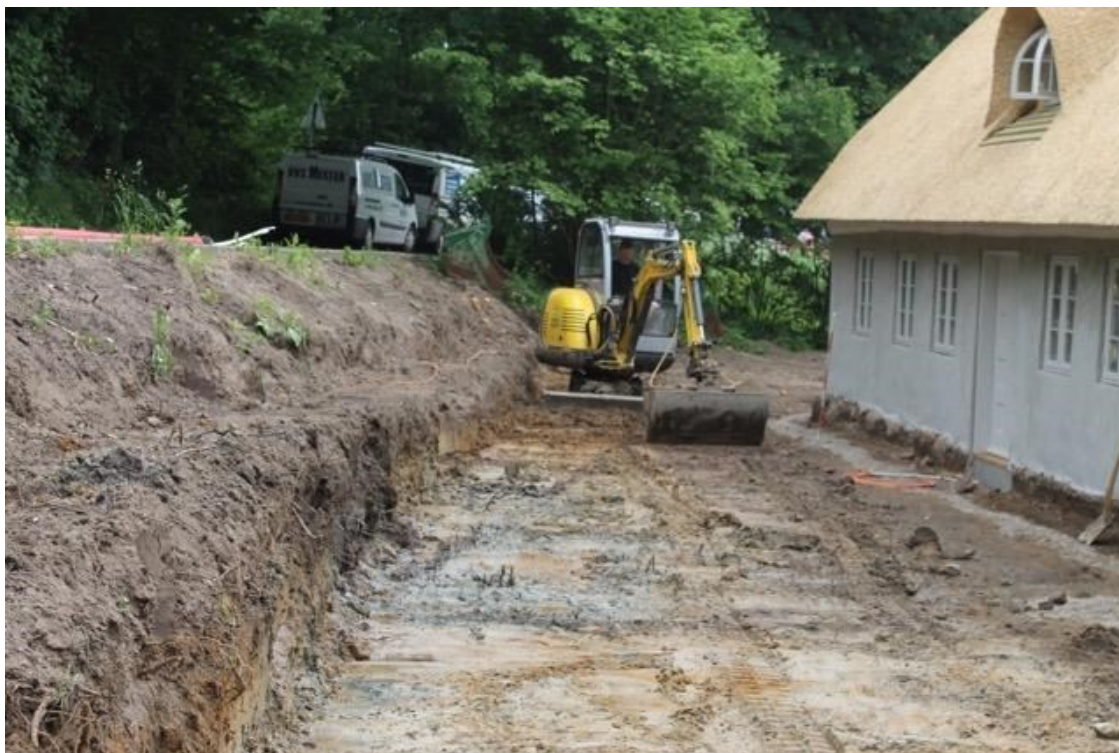
Billede 2: Afgravning og udjævning af terræn. Bemærk sokkelsten blotlagt. Foto: Henrik Hübschmann
