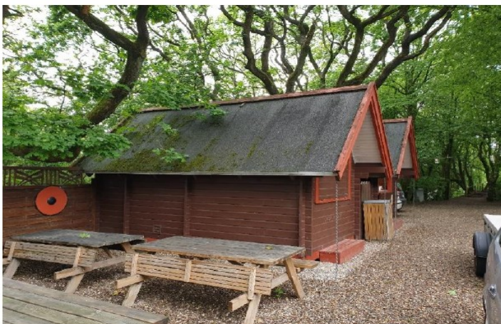
Den eksisterende dobbeltkiosk står for udskiftning.
