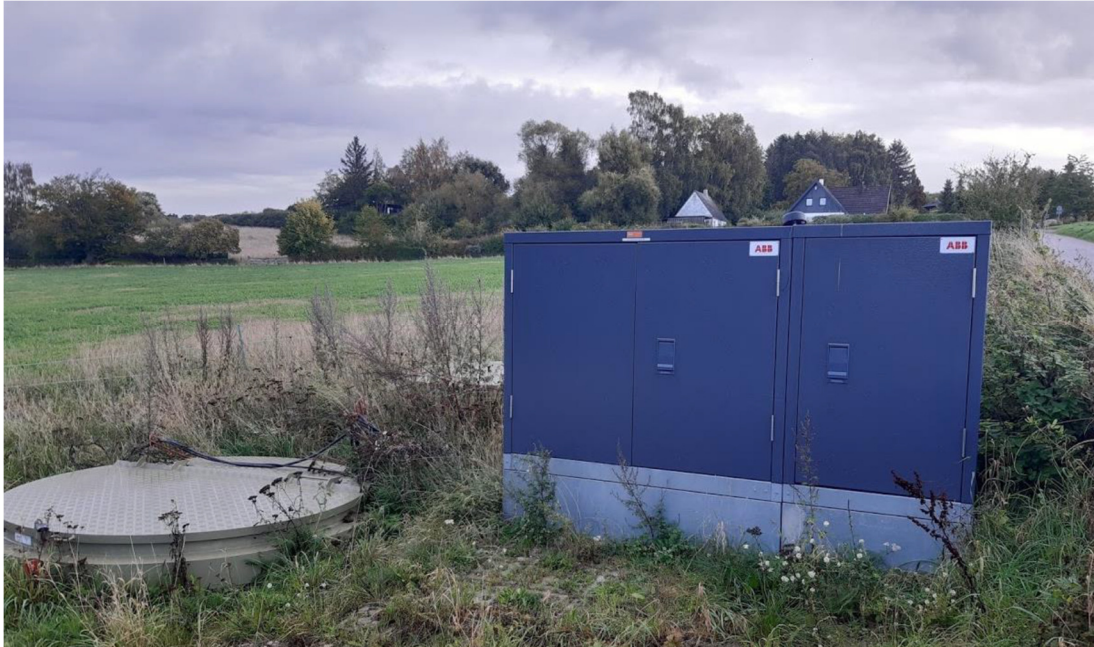
Billede fra FORS A/S af el- og styreskabet samt et af brønddækslerne.
