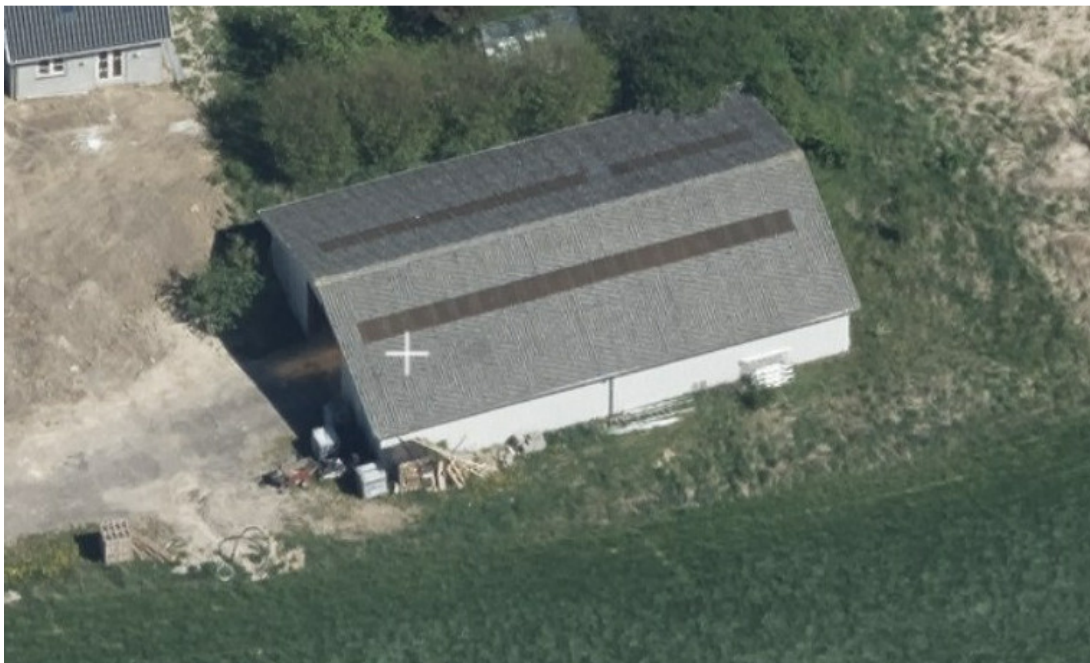
Skråfoto over hallen og den tagflade som solcelleanlægget ønskes placeret på.
