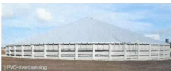
Billede 3. eksempel på en gyllebeholder med teltdug
