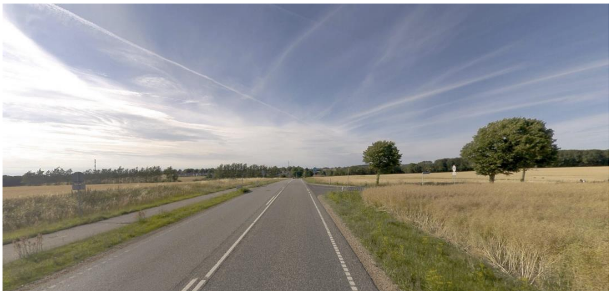
Kalundborgvej mod Havrebjerg – COWI gadefoto
