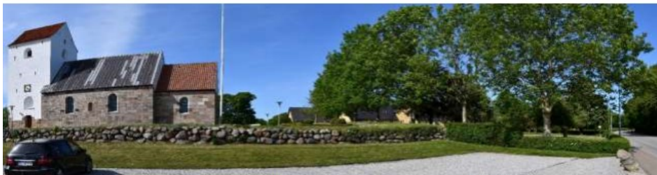
Foto 6. Præstegårdsgårdsbygning og konfirmandbygning ligger diskret nordøst for kirkegården
