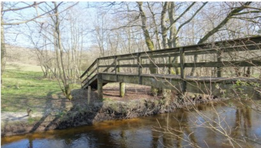
Broen syd for Højrisvej
