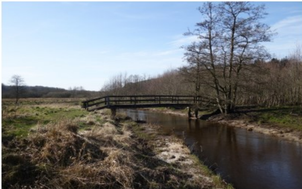
Broen nord for Højrisvej.
