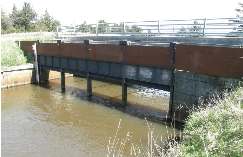
Figur 1. Højvandsslusen i Henne Mølleå set fra sydvest i maj 2010 med vejbroen på Porsmosevej i baggrunden og inden, at cykelbroen blev opført foran.
