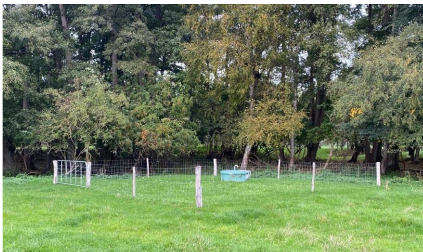
Figur 5: viser hvordan boring B10 i dag er afsluttet på terræn ved en ca. 50 cm høj glasfiberluge over den brønd som råvandsstationen i dag er placeret i under terræn.
