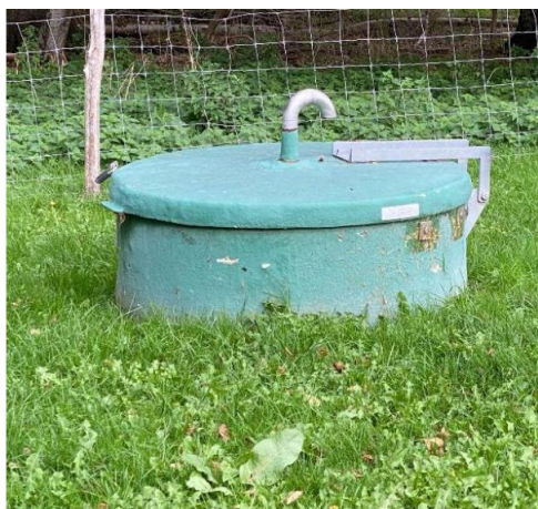
Figur 5: viser hvordan boring B10 i dag er afsluttet på terræn ved en ca. 50 cm høj glasfiberluge over den brønd som råvandsstationen i dag er placeret i under terræn.
