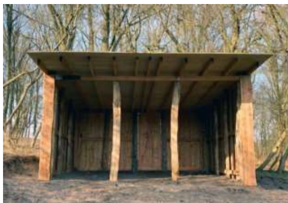
Læskuret bygges af FSC® certificerede pæle samt miljøvenlige materialer (som på billedet)
