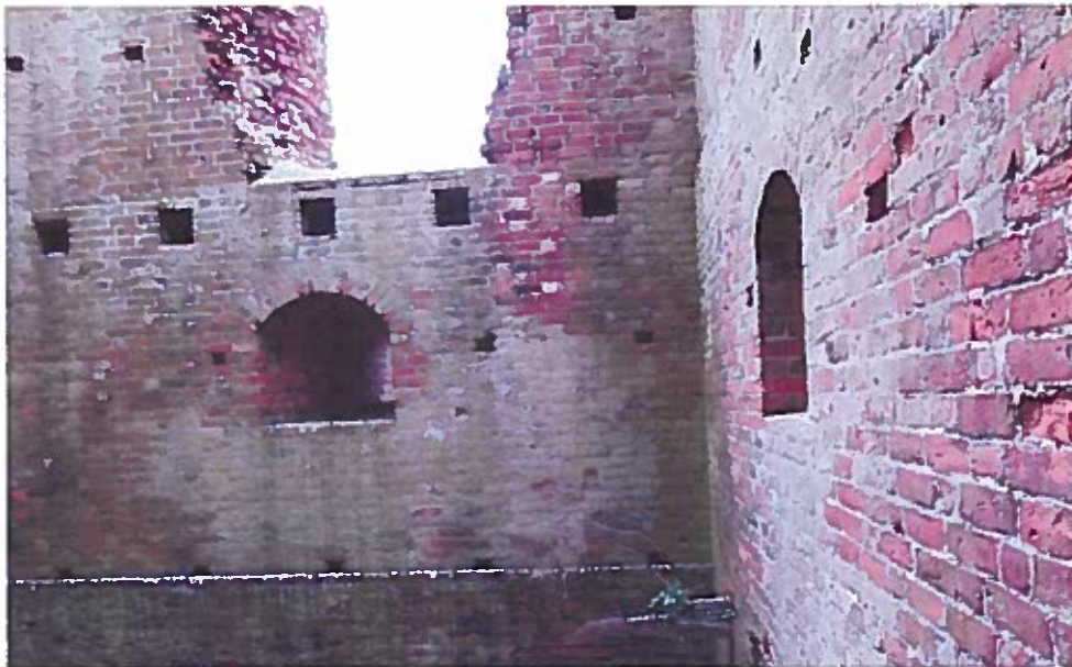
Ruinen set indefra. Der indrettes udsigtspost
