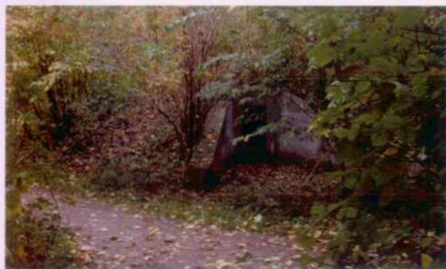
Den gamle ammunitionsbunker set fra nordvest
