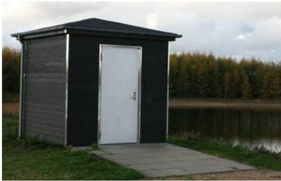
Billedet viser det nye toilethus.
