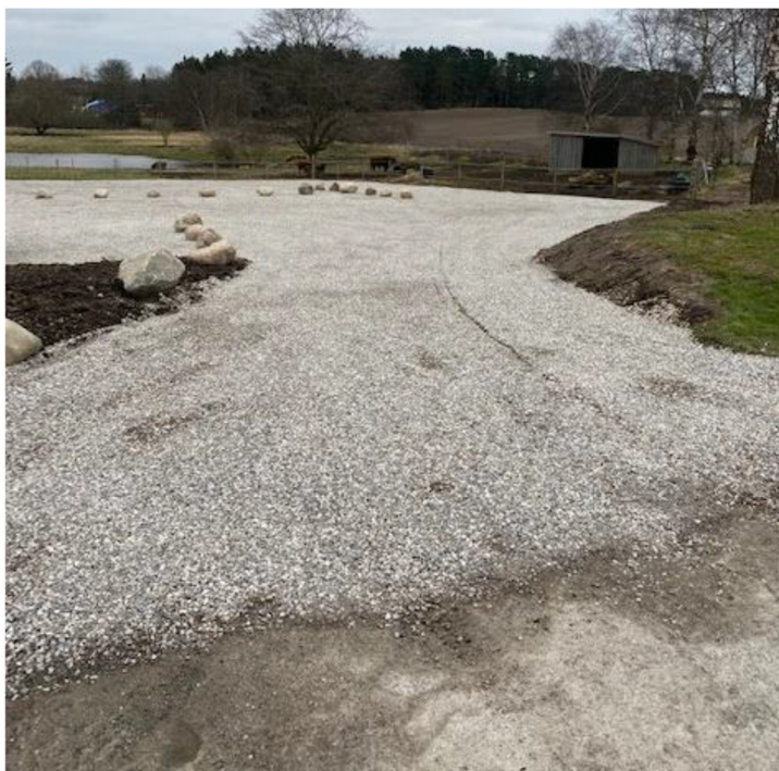
Billede 2. viser den nye del af parkeringspladsen, set fra indkørslen til den oprindelige parkeringsplads
