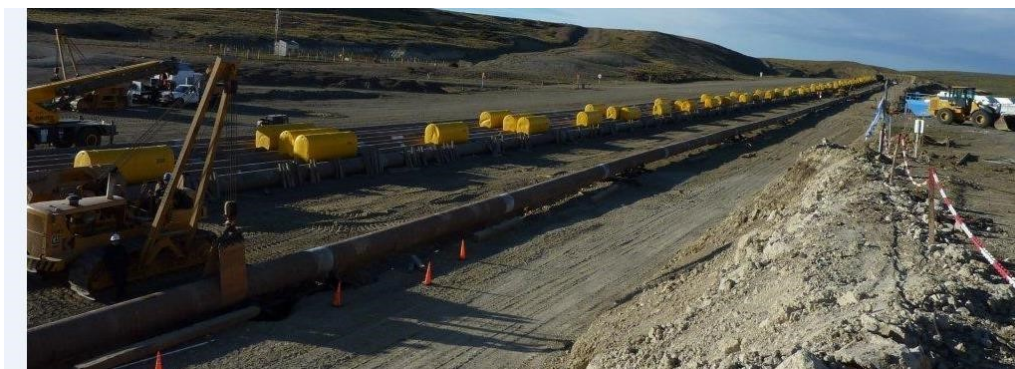
Figur 5 Eksempel på opstrengningsplads.
