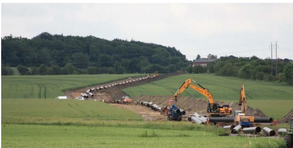
Figur 4 Arbejdsbælte ved anlæg af ny gasrørledning
