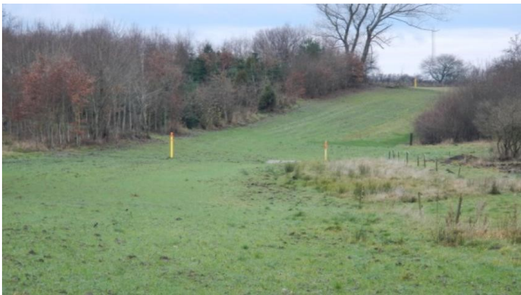
Figur 7 Eksempel på reetableret område efter anlæg af gasrørledningen. Gule markeringspæle skal placeres ca. for hver 500 meter. Pælene er ca. 1,2 meter høje.
