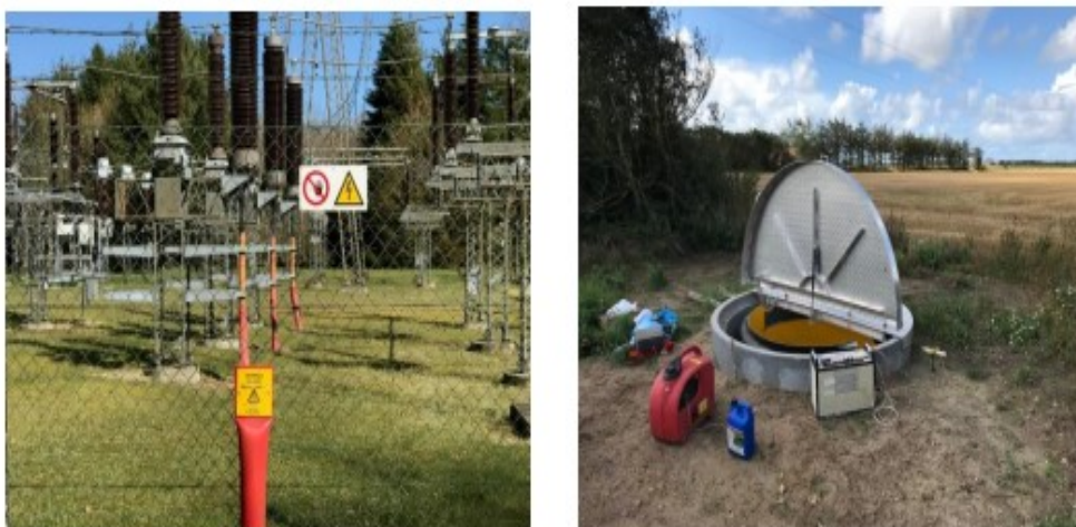
Figur 2-16 Eksempelfoto af markeringspæl og linkboksbrønd
