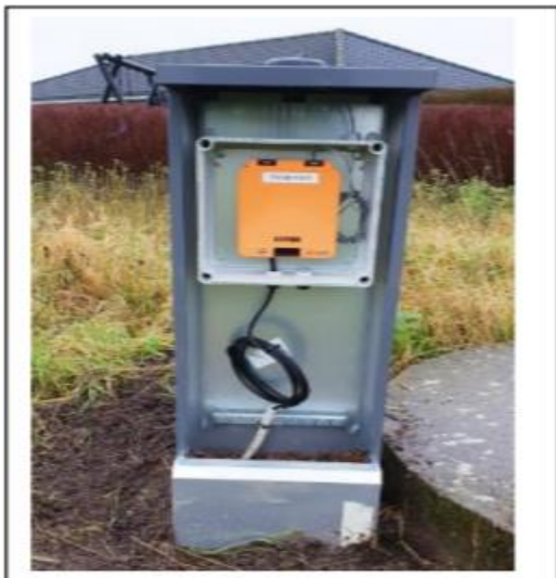
Foto af Sluse set fra inderside. Med sort er indtegnet mulig placering af styreskab 35*85cm samt 15cm. Rør til måleudstyr. Udstyr placeres, så der er adgang fra sti på dige.
