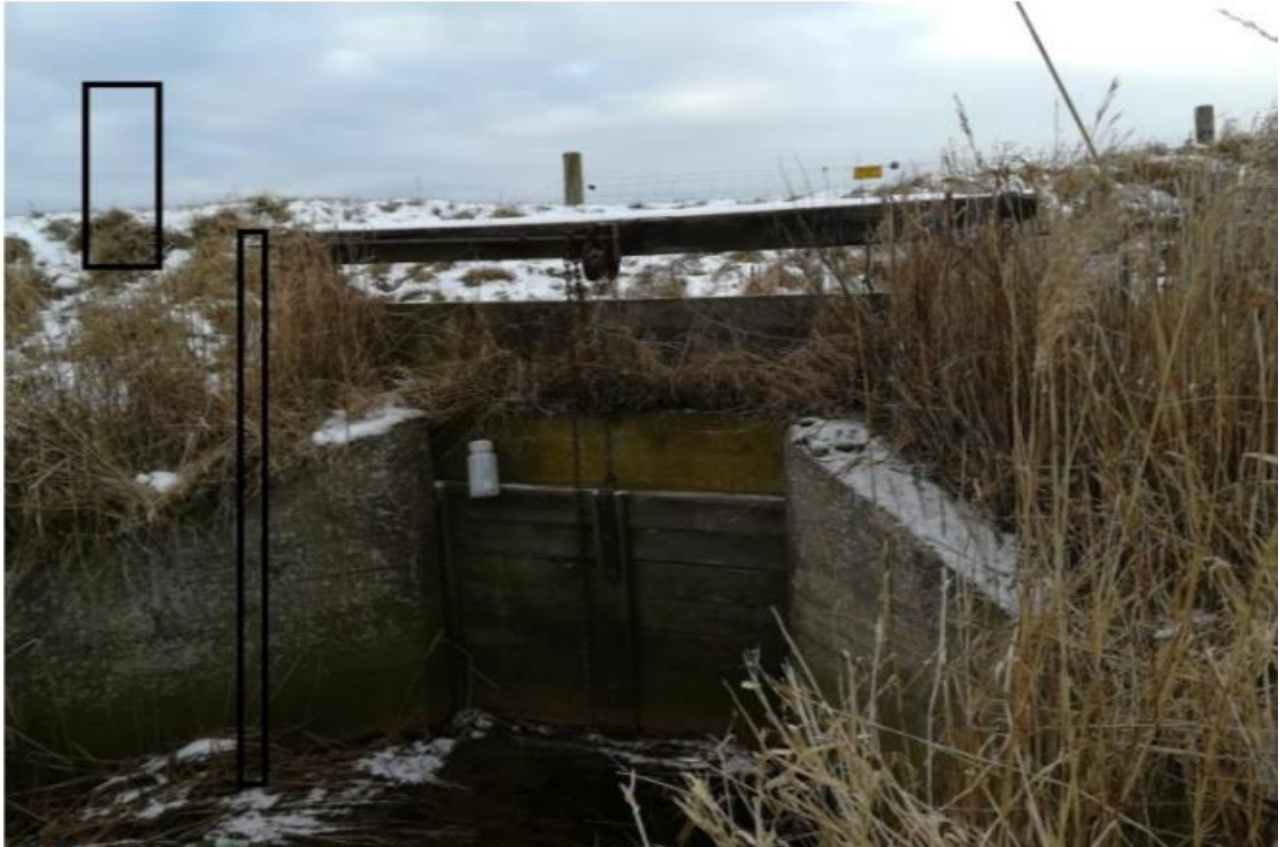
Foto af Sluse set fra inderside. Med sort er indtegnet mulig placering af styreskab 35*85cm samt 15cm. Rør til måleudstyr. Udstyr placeres, så der er adgang fra sti på dige.
