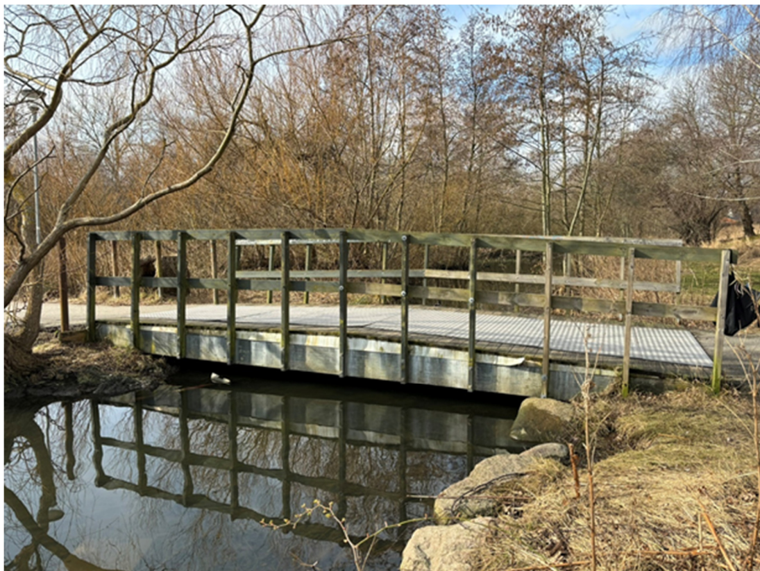
Billedet viser den gamle bro.
