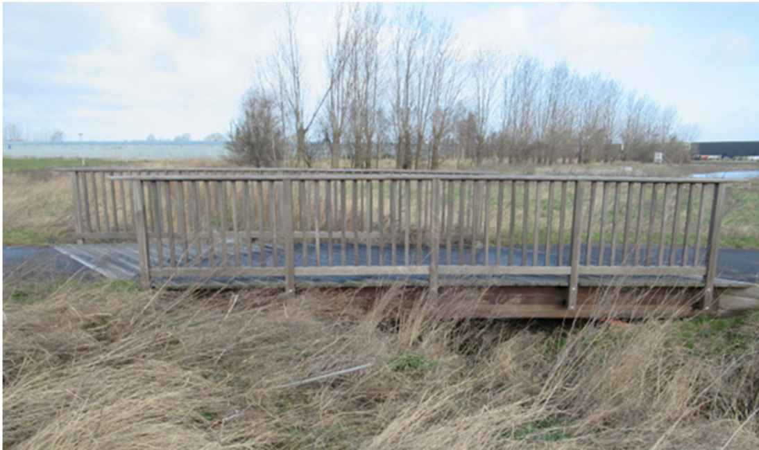
Billedet viser en tilsvarende bro som den nye, udført i azobétræ.
