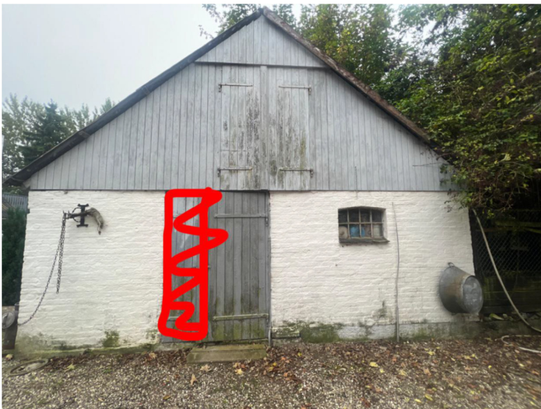
Billede med rød markering over den del af dørindgangen, som bliver muret op, da døren ønskes mindre end den nuværende.
