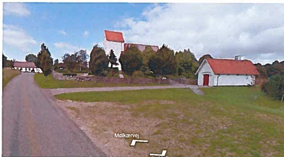
Figur 4: Eksisterende forhold ved maskinhuset
