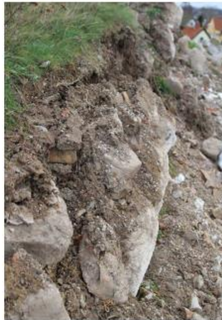
Foto 3 tv. Viser murens opbygning i knæpunktet det ses tydeligt at muren kun står på en enkelt række sten og overgangen til dobbelt mur ikke er understøttet.
