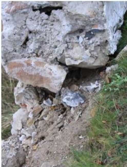
Foto 3 tv. Viser murens opbygning i knæpunktet det ses tydeligt at muren kun står på en enkelt række sten og overgangen til dobbelt mur ikke er understøttet.
