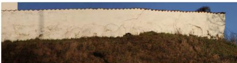
Foto 2. Udsnit af vestmuren visende den del der er væltet, (foto marts 2021)
