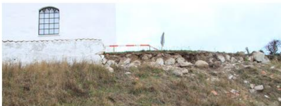
Foto 2. Viser muren væltet december 2021
