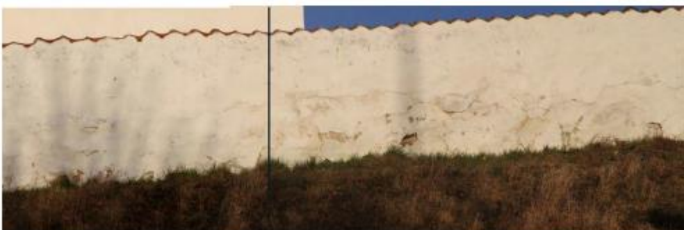
Foto 3. Udsnit af billedet ovenover med knæpunktet markeret med den sorte linje på muren. Det er murstykket til højre der er væltet. (foto marts 2021)
