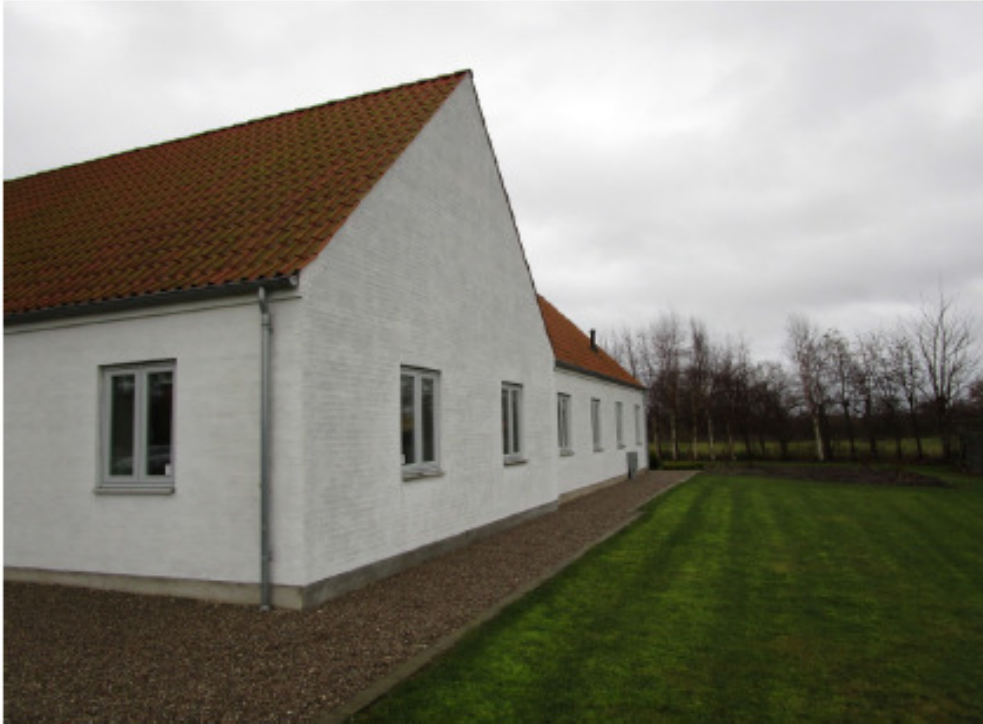
Facade mod vest - tilbygges i den sydlige ende
