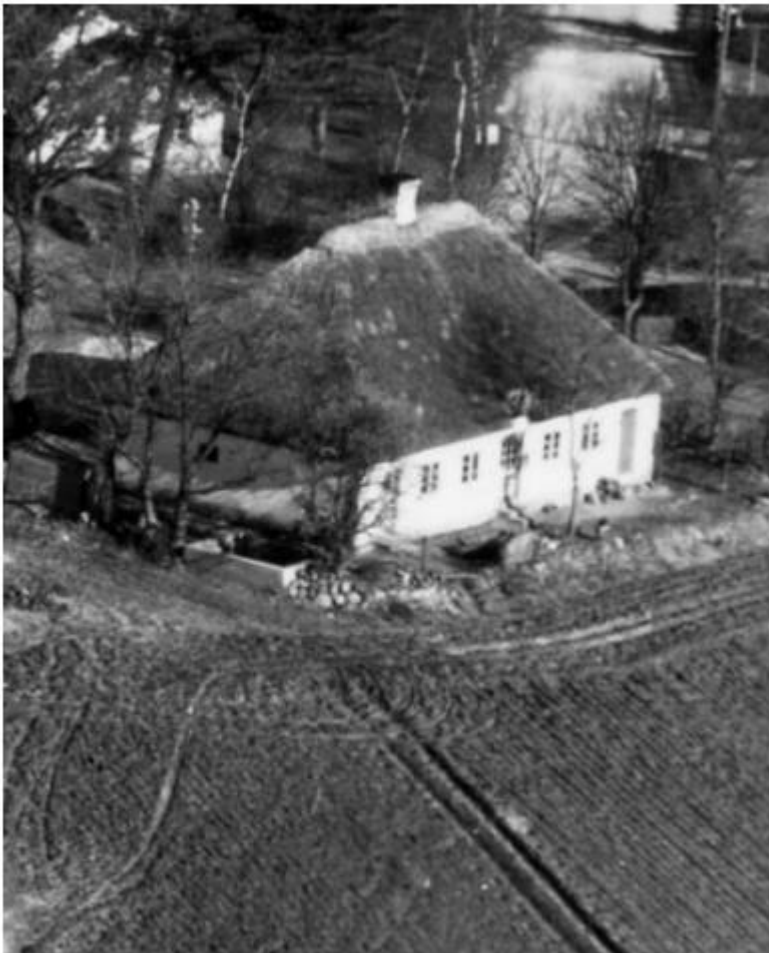
Røsnæsvej 327, set fra sydvest 1951 – før ombygning i 1970. Tag og facader formodes at være nogenlunde som ved opførelsen. Facaden mod syd har en dobbeltfløjet hoveddør med glasfyldning i det midterste fag og enkeltdøre i hver af de to yderste fag. Over det midterste fag ses en tagskægskvist. Skorstenen har "normal" størrelse og er afslutte for oven med en udkragende gesims.
