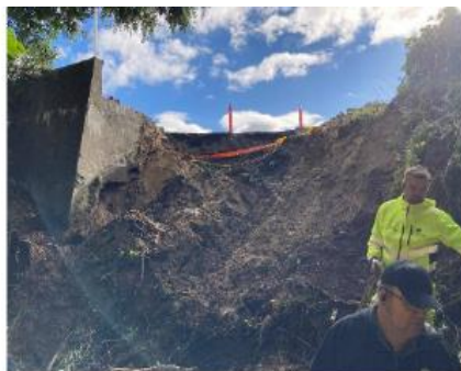
Foto 2: Skade efter skybrud. Kraftig erosion i skråninger
