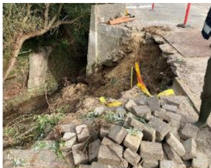
Foto 1: Skade efter skybrud. Eksisterende støttemur er væk, fortov er bortskyllet. Kraftig erosion i skråning
