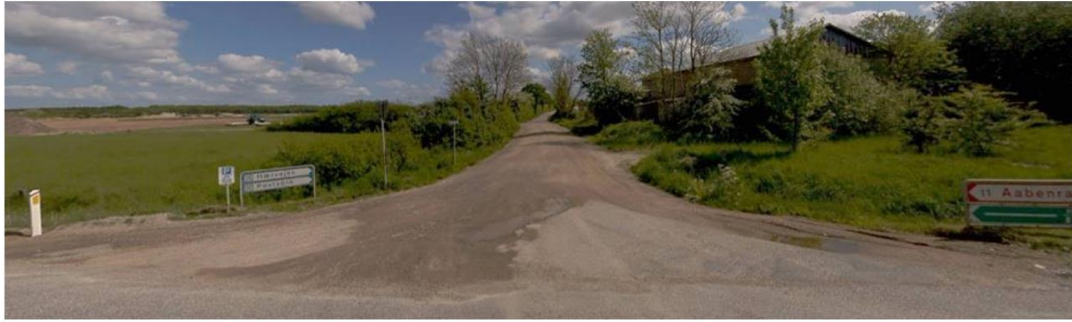
Stykket der søges asfalteret set fra nord ind ad Oksevejen.
